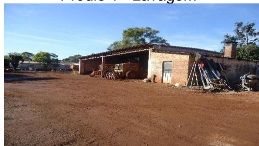
Garagem existente – a demolir
