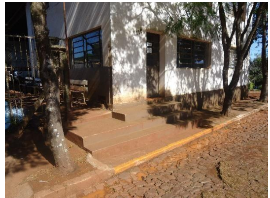
Prédio 1 – Acesso de pedestres existente
