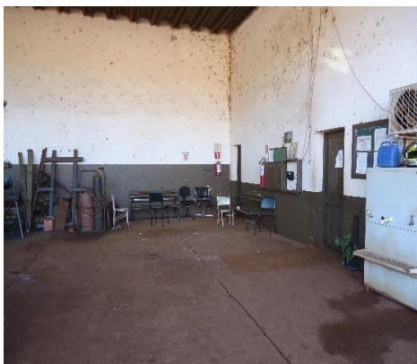
Prédio 3 – piso a reformar
