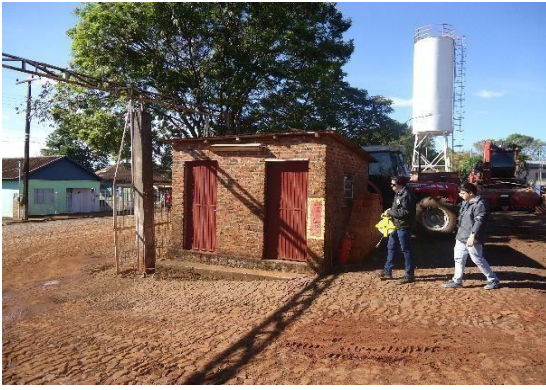
Prédio 4 - a Reformar
